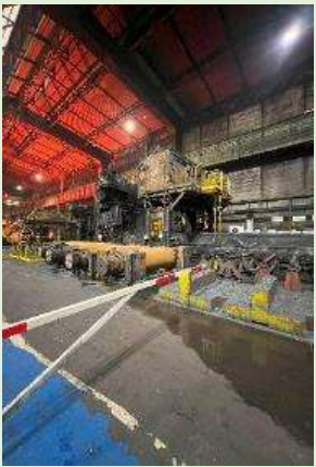
Barrières de sécurisation
